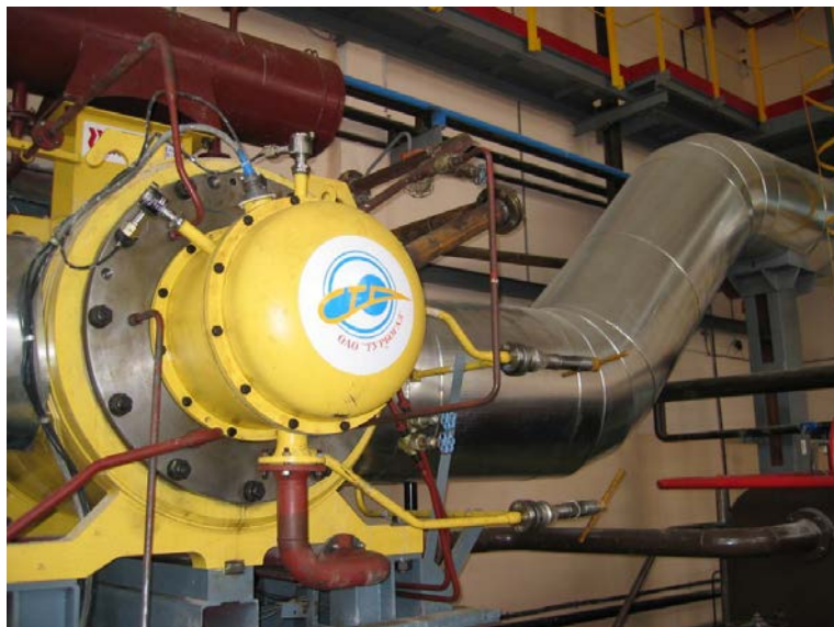
Рисунок.4. Утилизационная установка УДЭУ-2500. Турбодетандерный агрегат.
