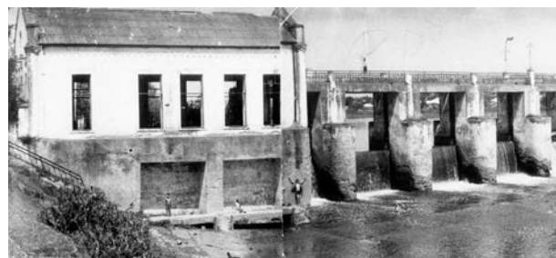
Fig.8. Clădirea MCHE și barajul la Căzănești pe r. Răut echipată cu 2 turbine verticale Francis de 117 CP la Q=3,6m^3/s, H=3m; n=96rot/min , generator 125KVA
