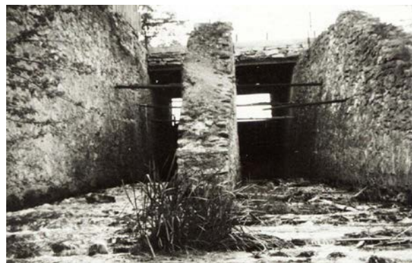
Fig.12. Locul montării la barajul Corjeuți a roții de apă
