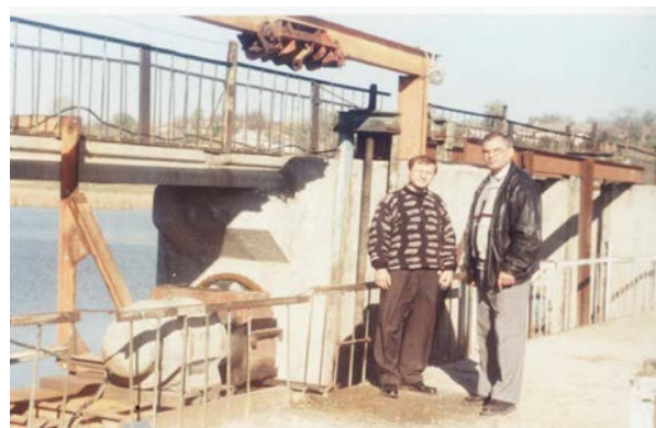
Fig.13 Hidroagregat cu roată de apă s.Varvareuca, Răut
