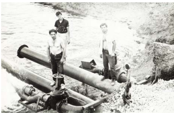
Fig.10. Primele 2 hidroturbine axiale de putere 5 kW ce au fost montate la bar. Tîrnova,Ed pe r.Racovăț
