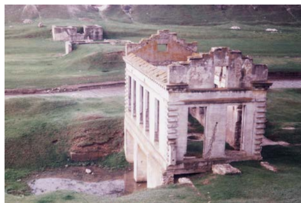
Fig.9. Clădirea CHE și barajul la Jeloboc-Piatra r. Răut echipată cu 2 turbine verticale Francis de firma Voith cădere H=3,6m ; cu generatoare Siemens de N=90kW
