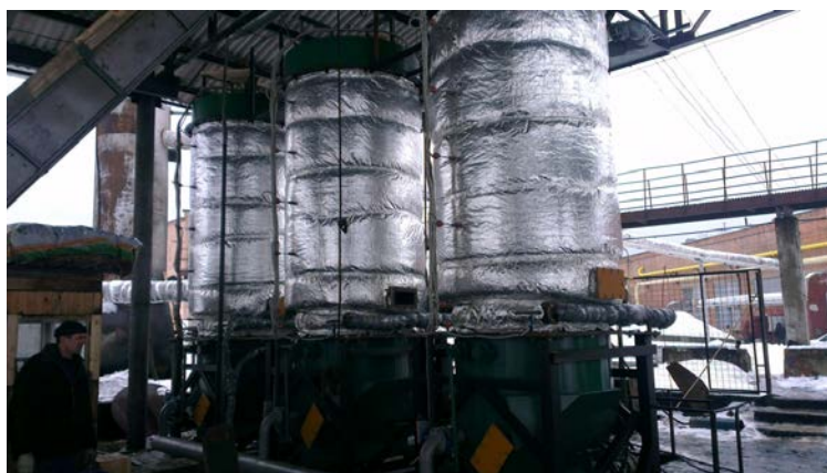
Рис. 3 Газогенератор эксплуатационной мощностью 2 МВт (Малиньска бумажная фабрика)
