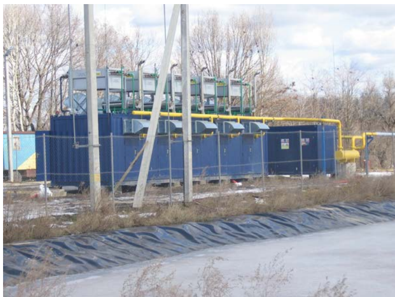
Рис. 2 Комплекс по переработке свалочного газа производительностью 1 МВт (Киевская обл., полигон №5)
