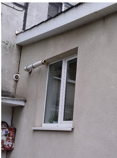
Figura 6a Exemplu de montare a unui coș de fum în mun. Chișinău
