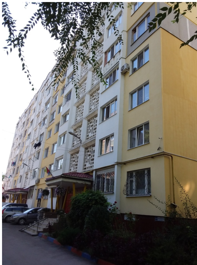
Figura 11. Vedere a blocului de locuit din strada Suceava 14A
