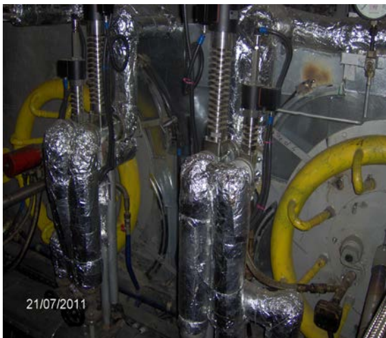
Fig.5 Vedere frontala front cazan cu arzatoare modernizate
