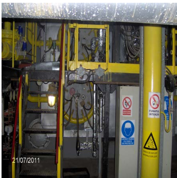
Fig.5 Vedere frontala front cazan cu arzatoare modernizate
