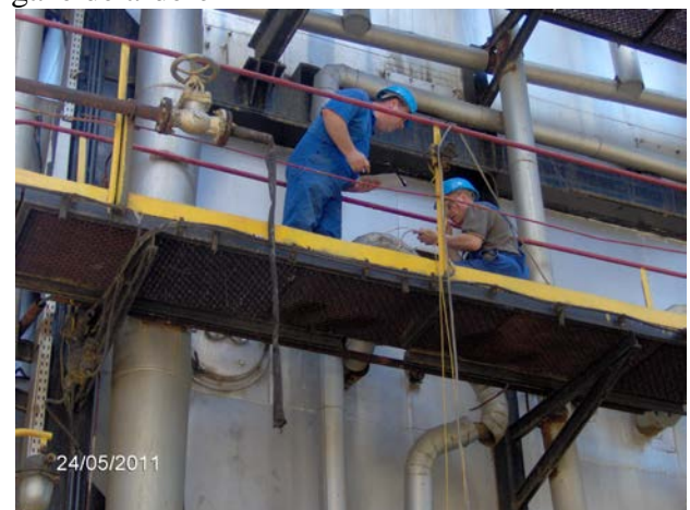
Fig.8 Efectuarea de teste si analize: analiza gaze de ardere
