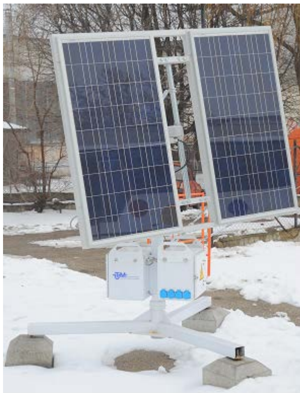
Fig. 4. Sistem autonom fotovoltaic cu orientare automatizată (SFVI).
