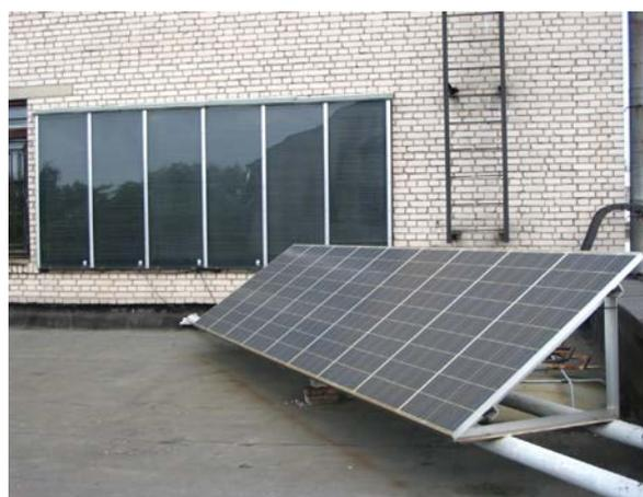
Рис. 2б. Солнечный тепловой коллектор и солнечный фотоэлектрический модуль
